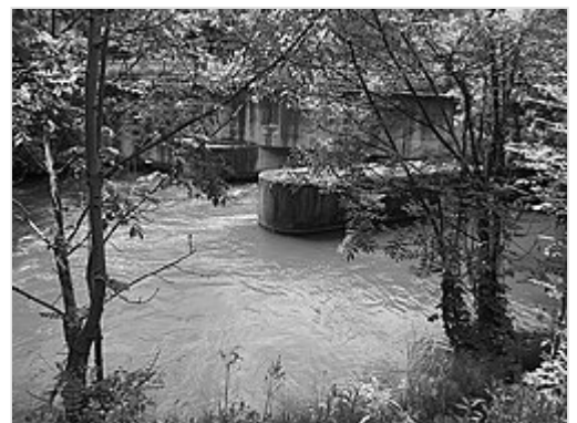
Hier am Mur-Ausleitungs-Kleinkraftwerk des KrW Weinzödl beginnt der Mühlgang am Nordrand von Graz (2013, noch ohne die über die Betonpfeiler gelegte Rinne der etwa 2016 errichteten Fischaufstiegshilfe )
