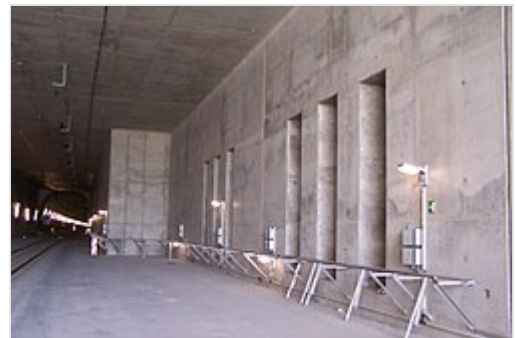
Schlitze in der Mittelwand der südlichen Portalhaube des Katzenbergtunnels . Im Hintergrund links ist der Beginn des eigentlichen Tunnelbauwerks zu erkennen.
