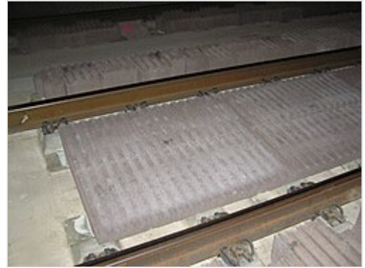
Schallabsorber im Euerwangtunnel
